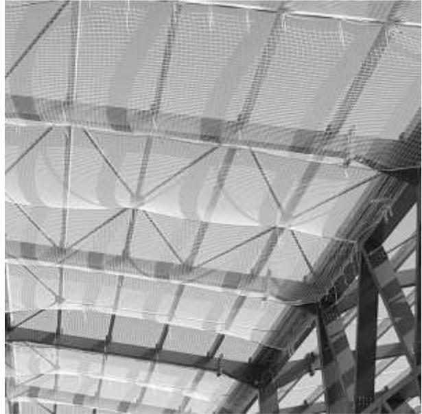
**Sistema U:** è una rete utilizzata in verticale con una intelaiatura ed un sostegno attaccato alcune volte un telaio proprio, fornito dal costruttore. Il collegamento e l'aggancio alla intelaiatura di sostegno avviene tramite idonea fune o cinghia.
