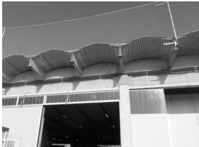
**Sistema T:** è la rete di sicurezza attaccata telaio di supporto generalmente di metallo per essere utilizzato orizzontalmente. Usualmente rispetto al sistema S ha uno sviluppo superficiale inferiore e si presenta come una mensola attaccata alla parete esterna verticale di un edificio.
